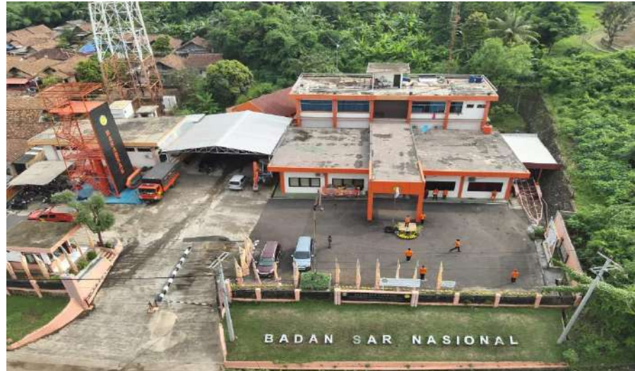
Gambar 1.2 Gedung Kantor Pencarian dan Pertolongan Banten
